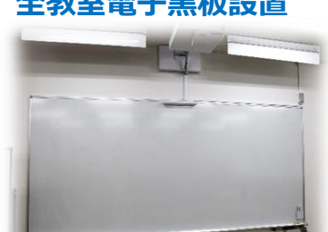
全教室電子黒板設置
